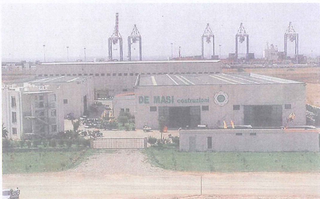
Lo stabilimento della "De Masi costruzioni" nell'area industriale di Gioia Tauro è nel mirino della criminalità organizzata
